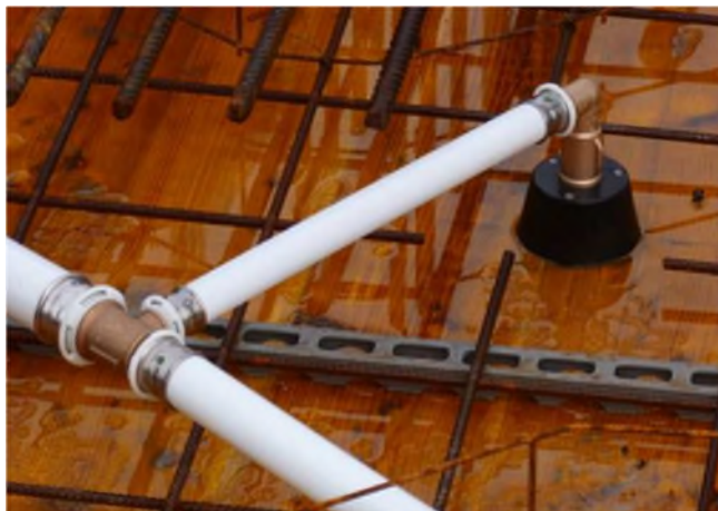
Figuur 21: leidingen voor stort van plafond
