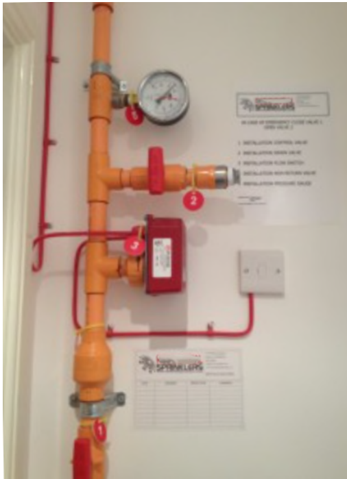
Figuur 18: Aansluiting woningsprinklerinstallatie
