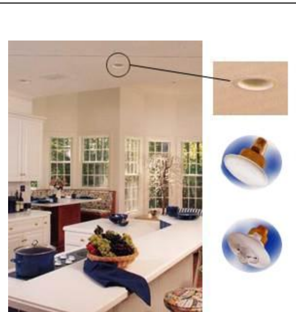
Van een woningsprinkler is niet meer te zien dan een wit plafondplaatje
