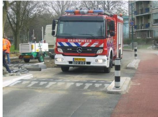
Woningsprinklers maken het onder meer mogelijk om de wijken autoluw te hebben zonder dat de opkomst van de brandweer in het geding komt.
