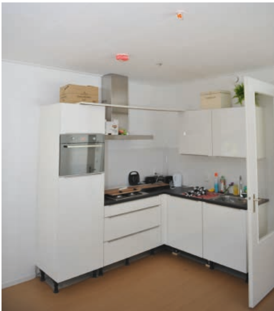
Rookmelder én woningsprinkler bij een woonproject in Joure.
